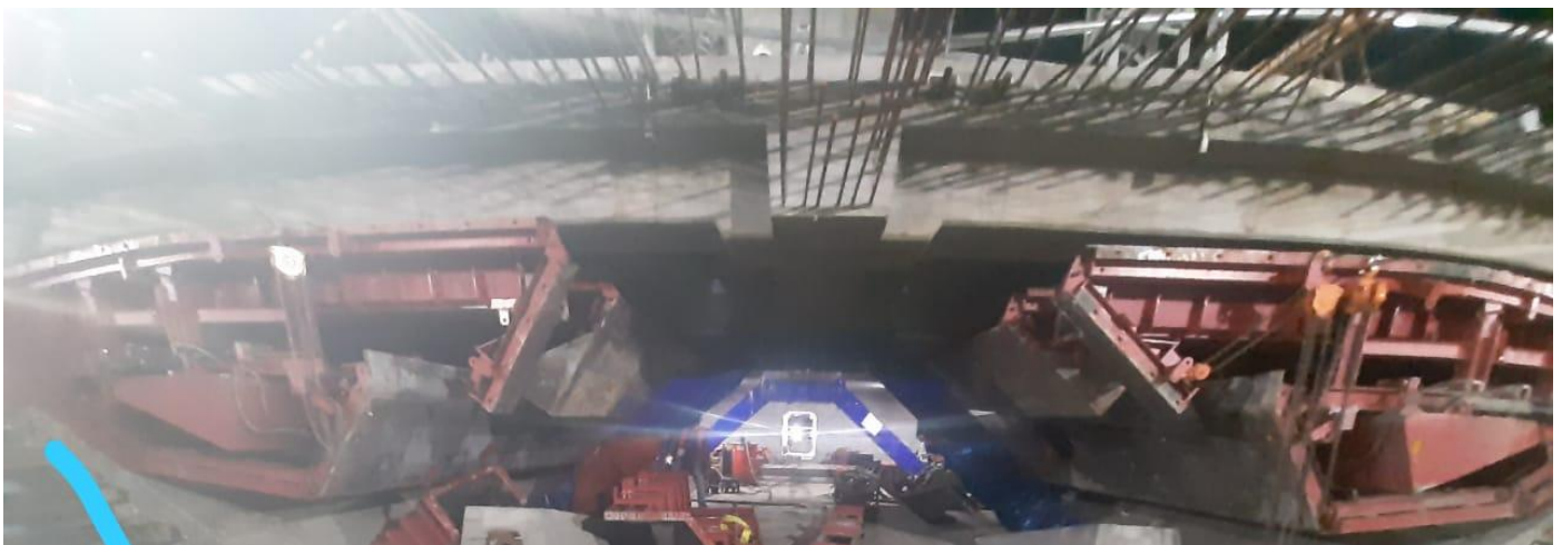
Figura 21: Encofrado interior plegado listo para el lanzamiento
