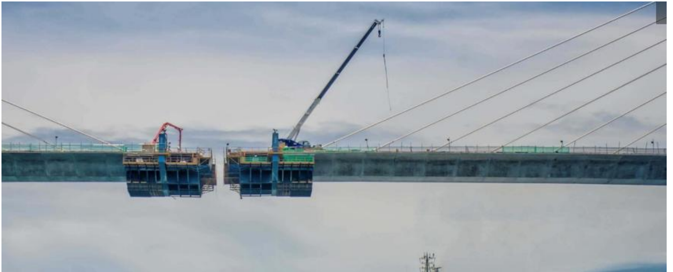
Figura 29: Últimos segmentos de hormigonado antes del segmento de cierre
