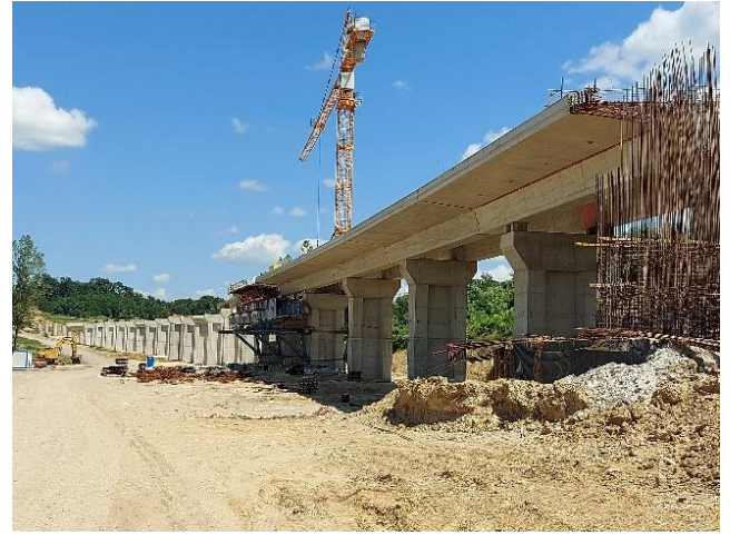
Figura 4: Pilares completados y construcción del tablero
