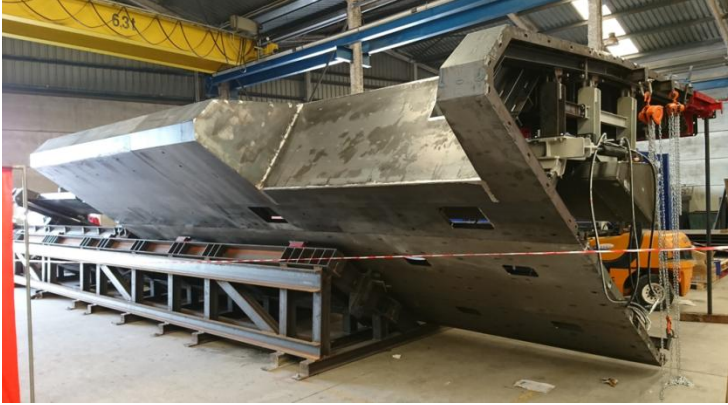
Figura 22: Encofrado interior durante la prueba de aceptación de fabricación (FAT)
