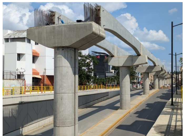
↓ Figuras 8 y 9: Estructura de monorraíl en construcción
