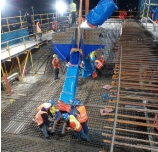
Figura 34: Instalación del anclaje del tirante
