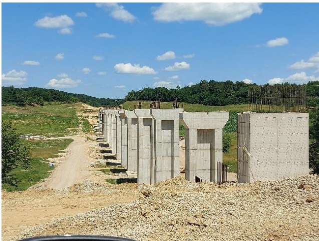
Figura 4: Pilares completados y construcción del tablero
