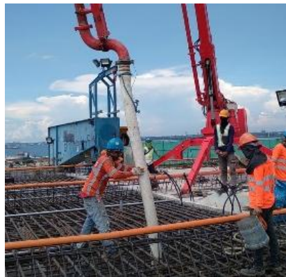
Figura 37: Hormigonado
