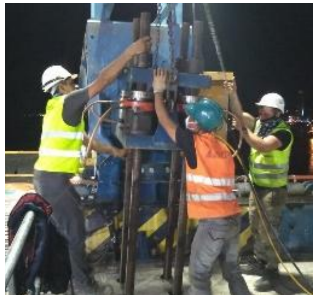
Figura 31: Retirada de los anclajes de soporte principales del carro encofrado para transferir el peso del carro encofrado a los riles de lanzamiento
