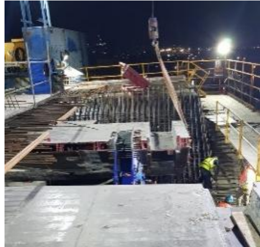
Figura 35: Lanzamiento del encofrado interior
