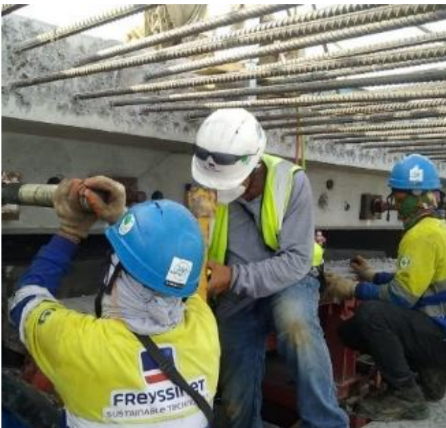
Figura 30: Colocación y pretensado de barras PT
