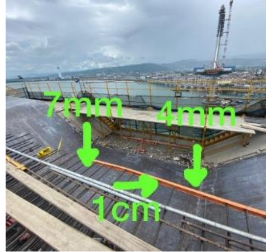
Figura 33: Ajuste del carro para la nueva posición de hormigonado
