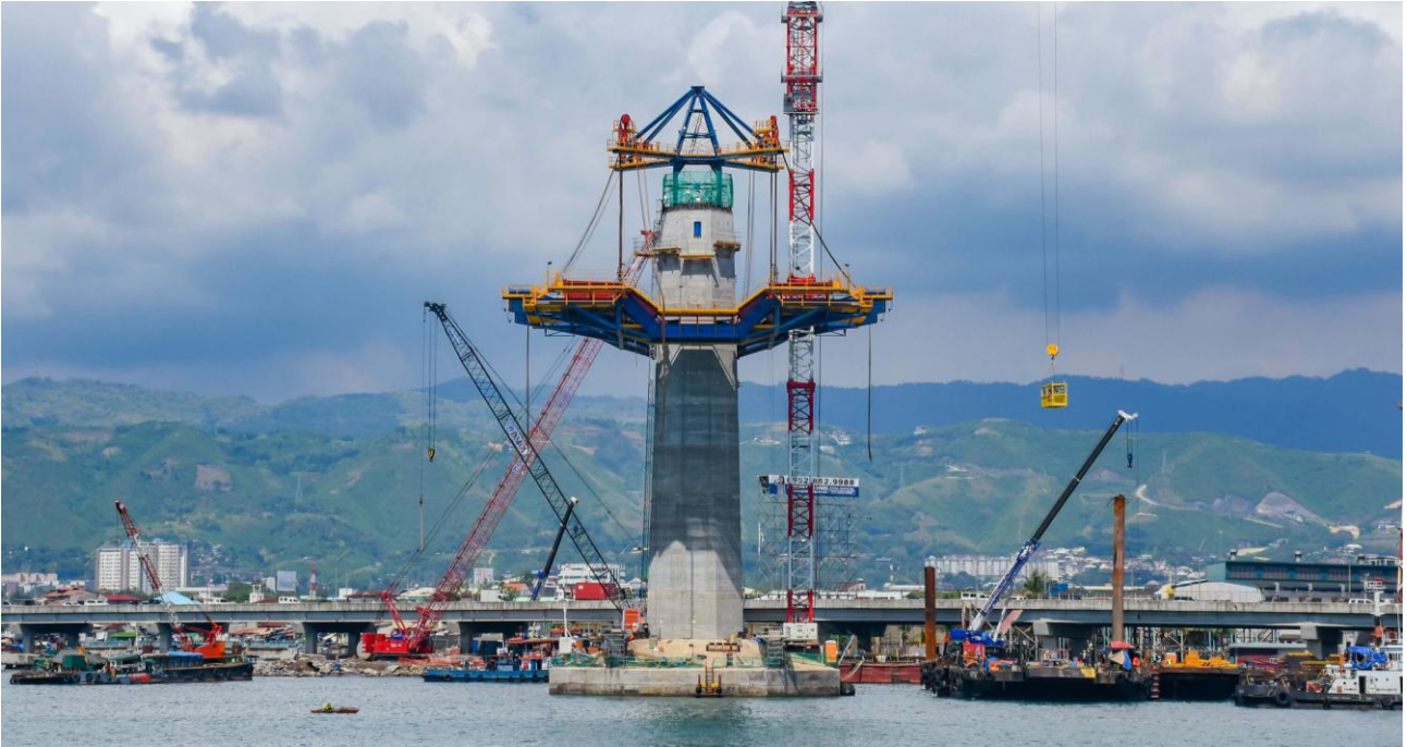
Figura 2: Izado de la pareja de carros para la ejecución de la cabeza de pila
