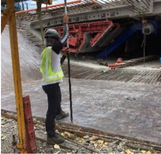
Figura 32: Lanzamiento de los encofrados exteriores y control topográfico
