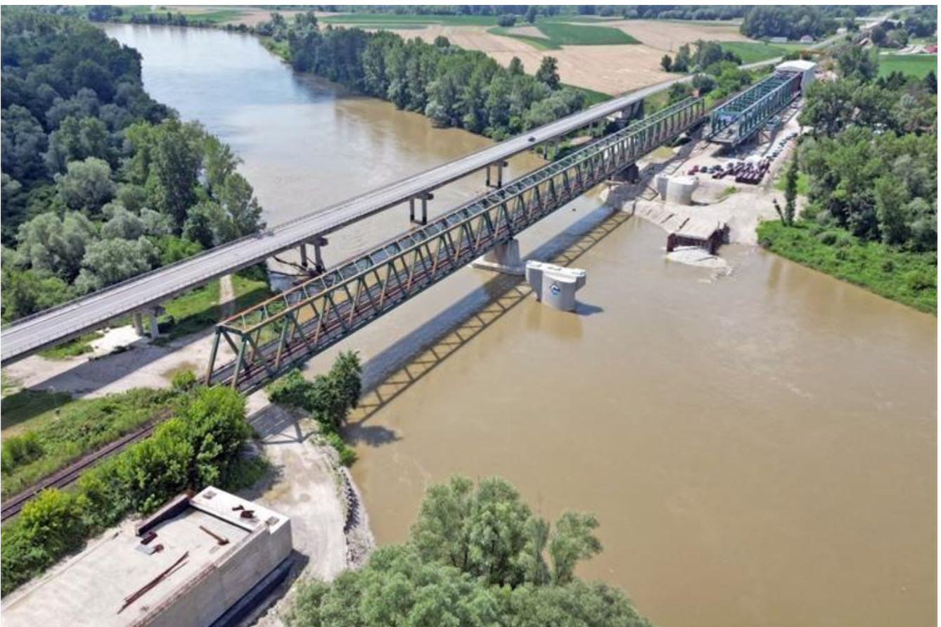
Figura 2: Vista aérea del puente sobre el río Drava
