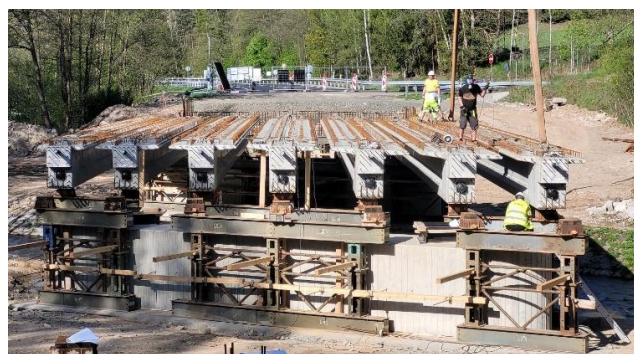
Figura 8: Vigas prefabricadas durante la fase de construcción
