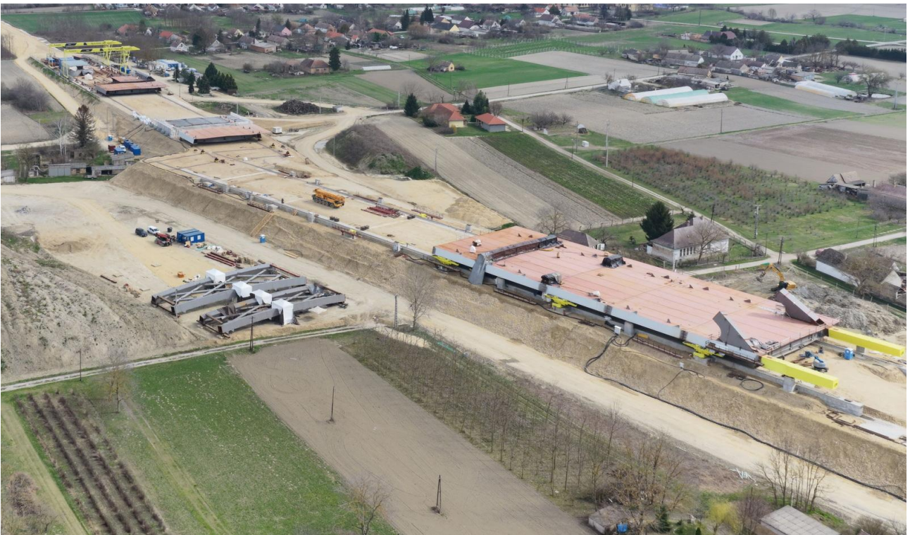
Figura 35: Lugar de montaje de la estructura B1-B2, lado este - marzo de 2026 Fuente: Duna Aszfalt
