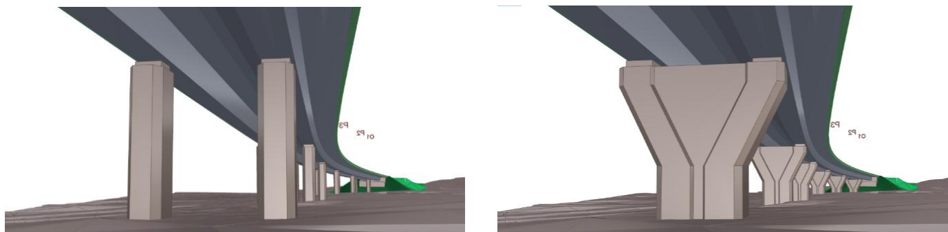
Figura 13: Comparación de configuraciones de pilares - Puente n° 201
