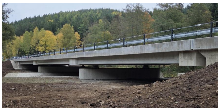
Figura 7: Vista lateral del puente terminado n.º 20-005
