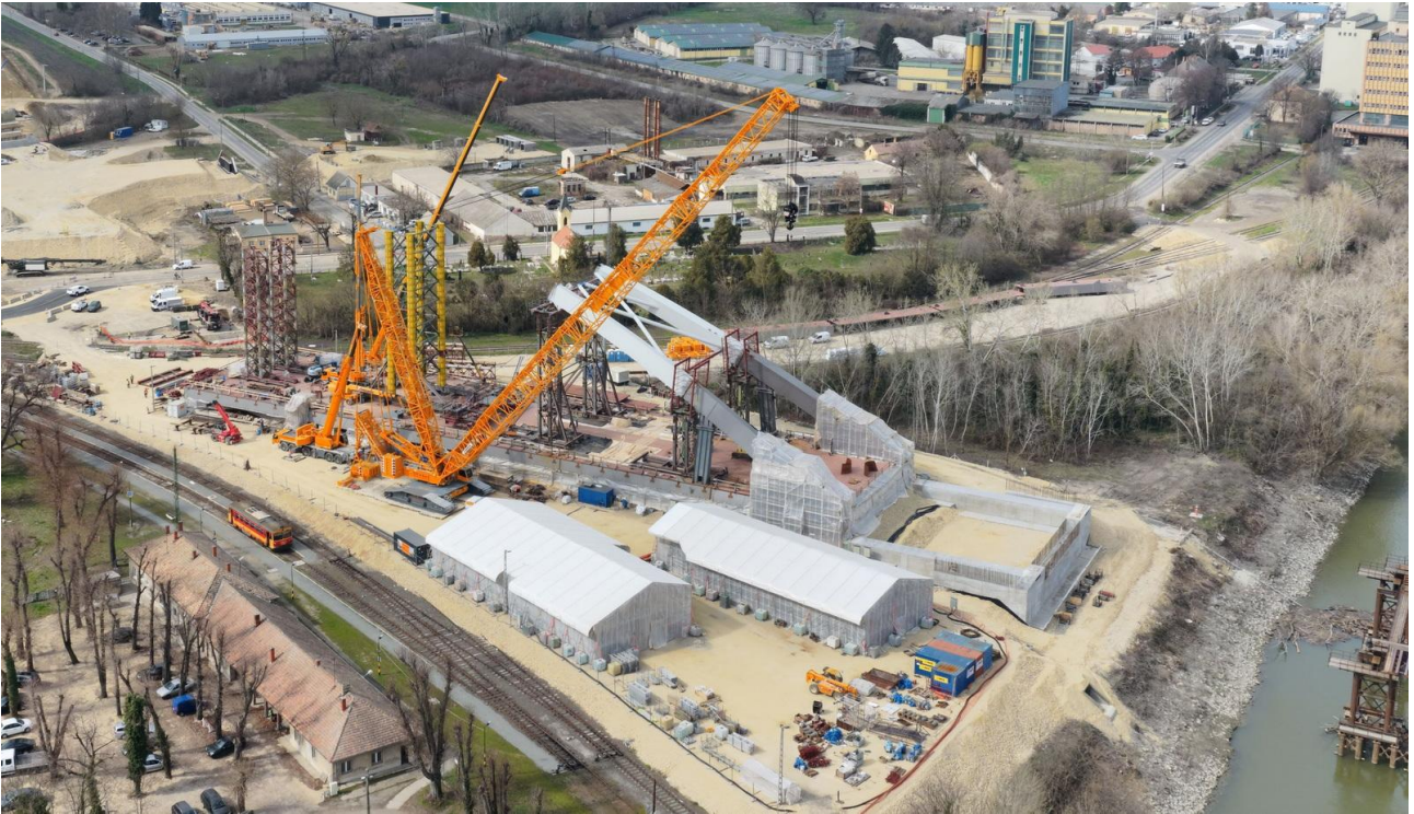
Figura 34: Lugar de montaje de la estructura B3, lado oeste - marzo de 2026 Fuente: Duna Aszfalt
