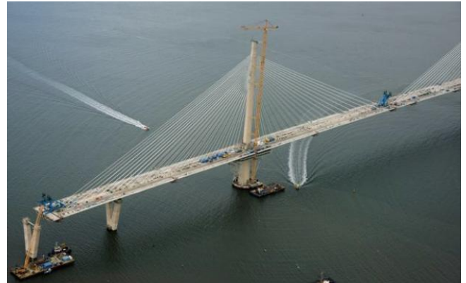
Construcción del puente de Queensferry, Reino Unido
