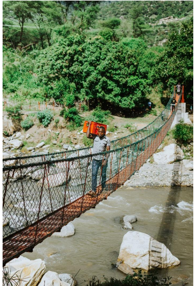
Figura 3: Puente Sisit terminado: restablecimiento de la conectividad de la región
