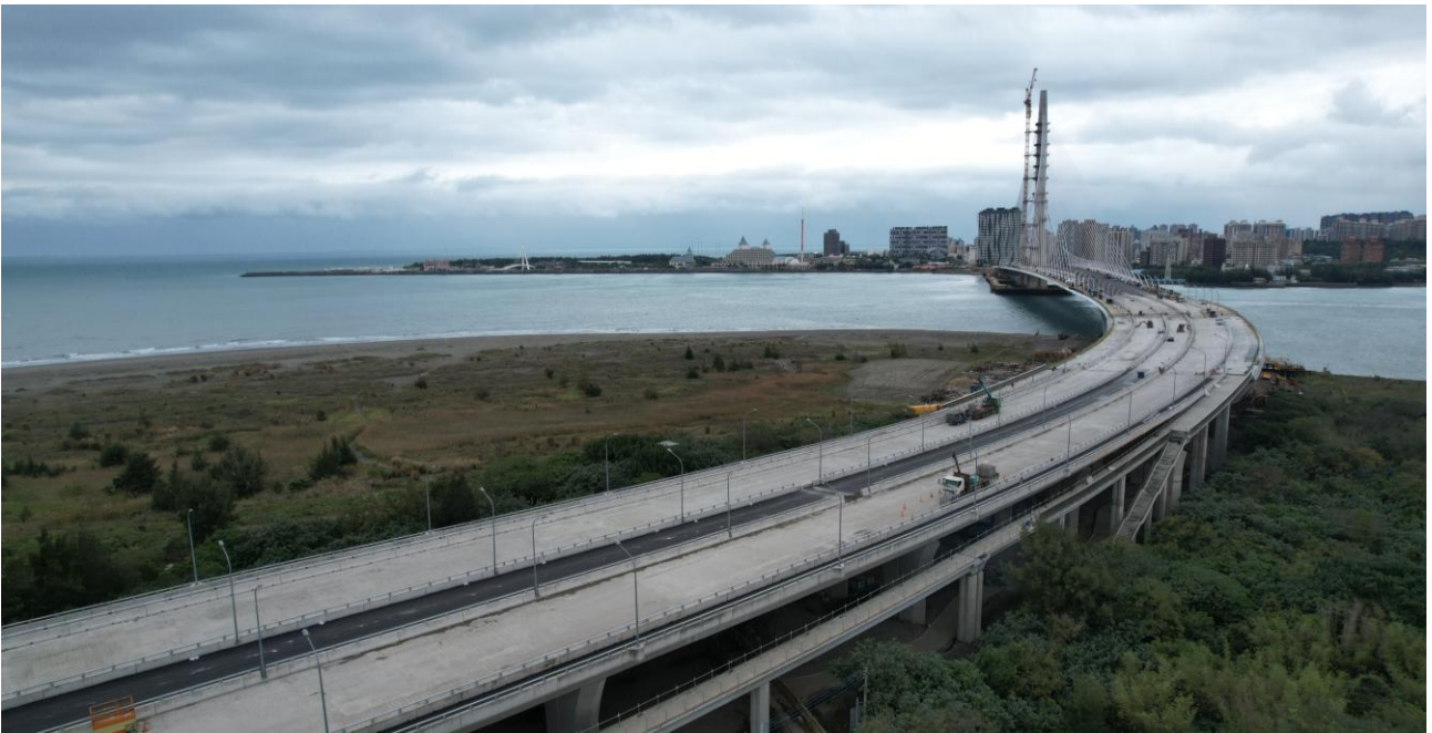
Figura 1: Puente terminado en enero de 2026 Fuente: Sinotech
