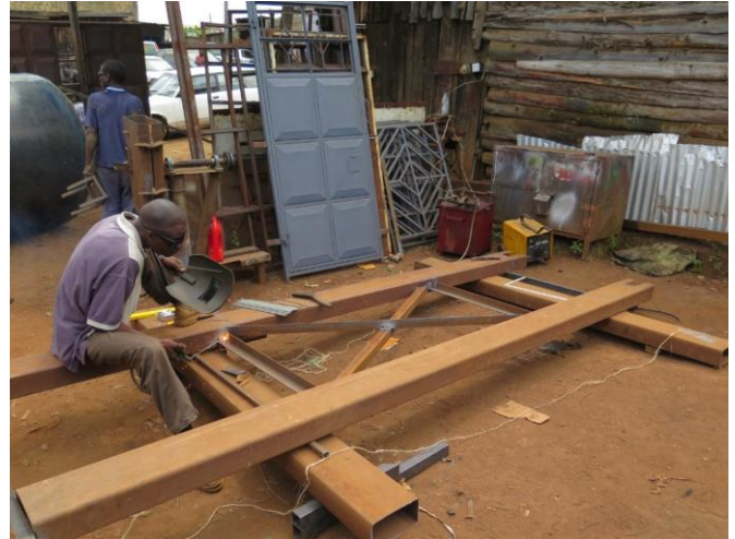
Figura 1: Herrero informal fabricando la torre de un puente colgante
