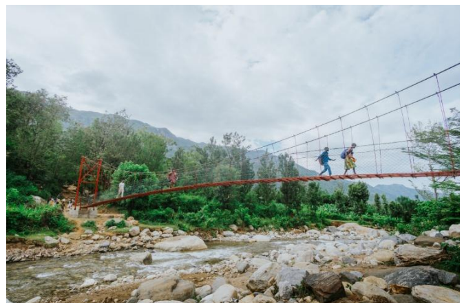
Figura 4: Puente colgante de Tamkal terminado
